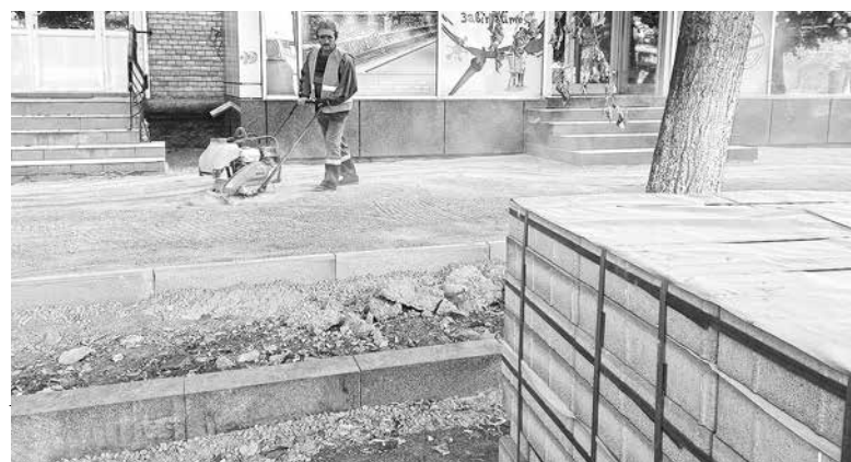
Підрядники обіцяють, що завдяки спеціальній суміші, на яку укладають плитку, вона не просяде і витримає навіть вагу вантажівки
